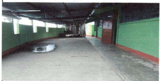
Foto 4: Sustitución de lamina, por lamina troquelada aluzinc calibre 26 y sustitución estructura de soporte de madera por metal
