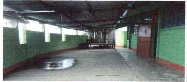
Foto 2: Sustitución de lámina, por lamina troquelada aluzinc calibre 26 y sustitución de estructura de soporte de madera, por meta
