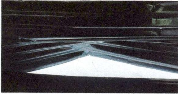
Foto1 Sustitución de lámina, por lamina troquelada aluzinc calibre 26 y sustitución de estructura de soporte de madera, por metal
