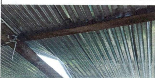
Foto 5: Sustitución de lamina por lamina troquelada aluzinc calibre 26
