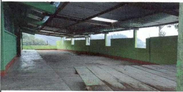
Foto 3: Sustitución de lamina, por lamina troquelada aluzinc calibre 26 y sustitución y estructura de soporte de madera por metal
